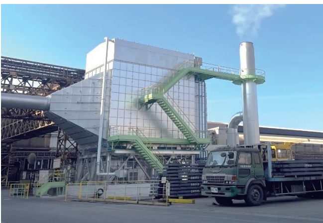
図11 更新後のHS集塵機写真
