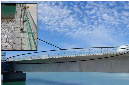
ステンレス鉄筋の適用事例
