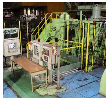
増強した圧延機と切断機
